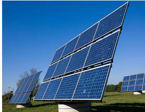
Figure I.3. Installation des panneaux photovoltaïques.
